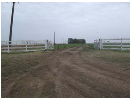
Ingreso al Establecimiento “San Bernardo”
